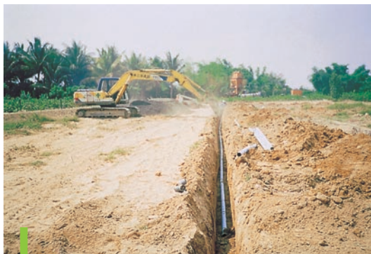
圖十二：排水暗管之埋設需於苗木定植前完成。（謝鴻業）
