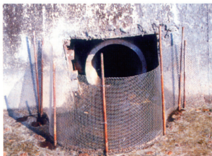
進水口裝置鐵絲網，可阻絕來自溝渠的福壽螺
