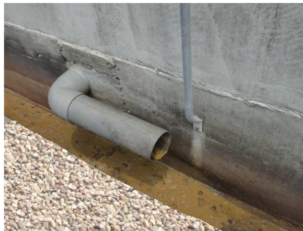
定期清洗排水管與排水溝
