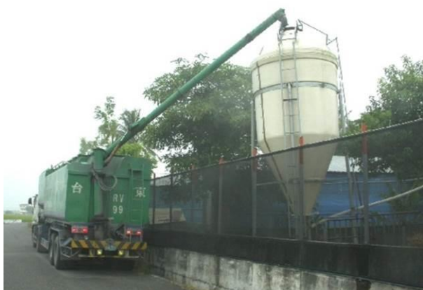
飼料車停於圍牆外，隔牆卸料。
